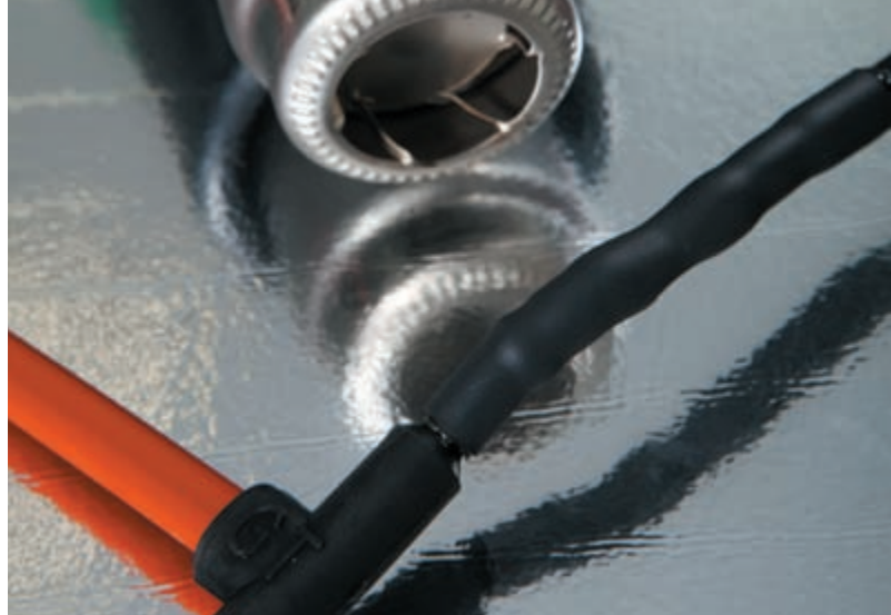
Рис. 14. Усадка термоусаживаемой трубки техническим феном
