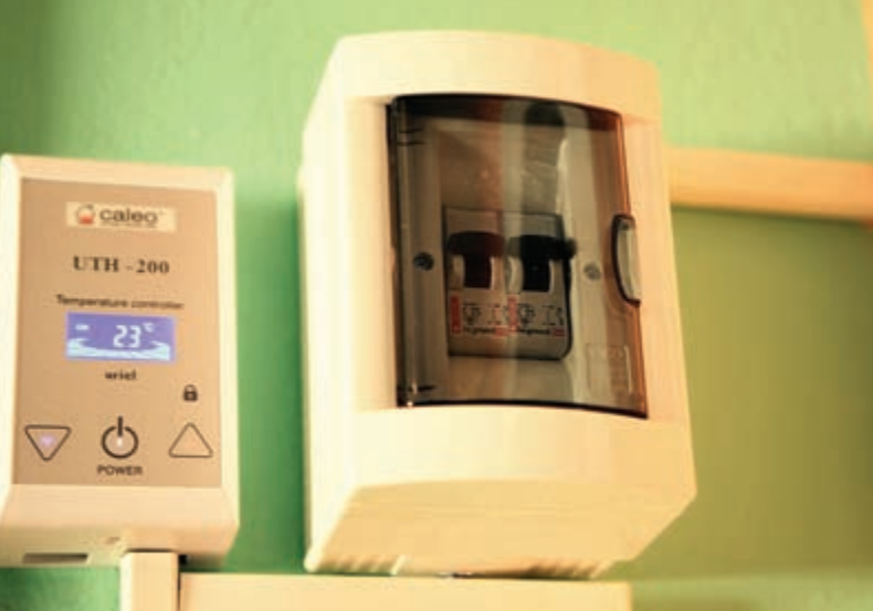
Рис. 20. Установленный терморегулятор на стене
