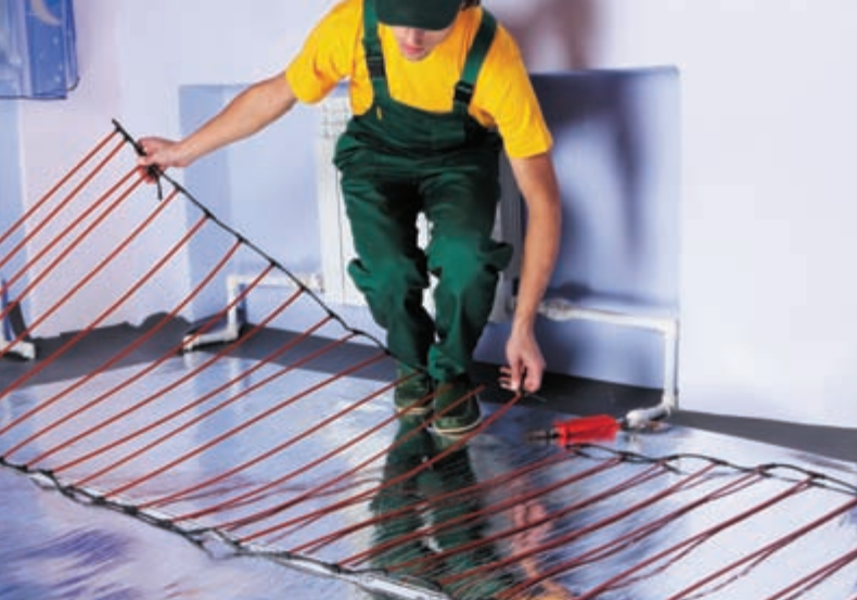
Рис. 9. Укладка разрезанной с одной стороны полосы UNIMAT на теплоотражающий материал с последующим разворотом мата
