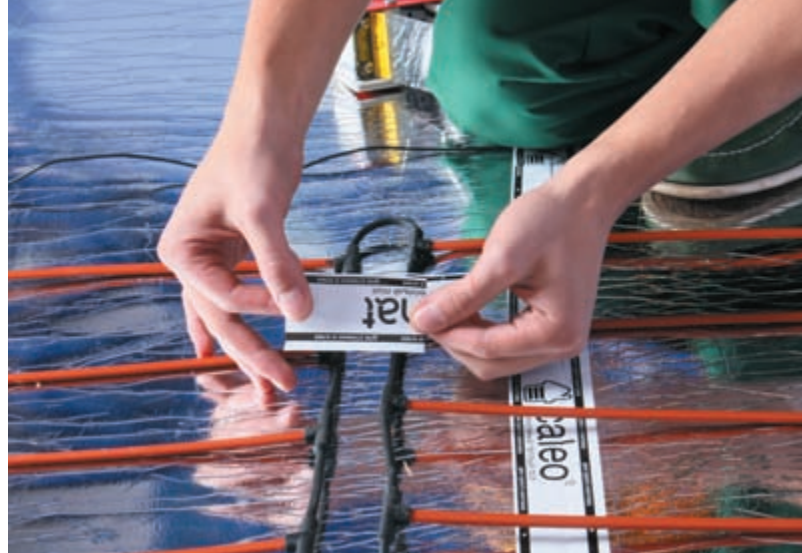
Рис. 10. Фиксация полос UNIMAT скотчем
