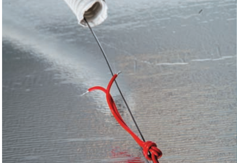
Рис. 17. Установка датчика температуры пола SF 4x15 в гофрированную трубку (начало).
