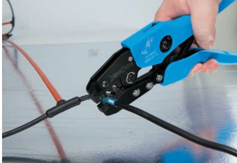
Рис. 12. Обжатие клещами соединительной гильзы
