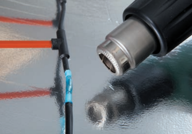
Рис. 13. Термоусадка соединительной гильзы техническим феном
