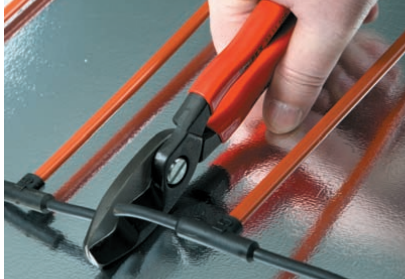
Рис. 8. Пример правильного разделения UNIMAT
