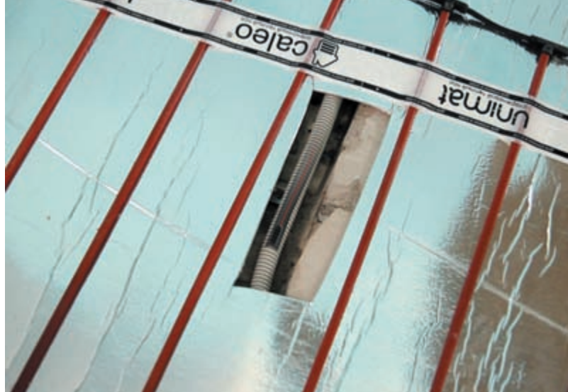
Рис. 19. Установка датчика температуры пола SF 4x15 между стержнями UNIMAT в гофрированной трубе
