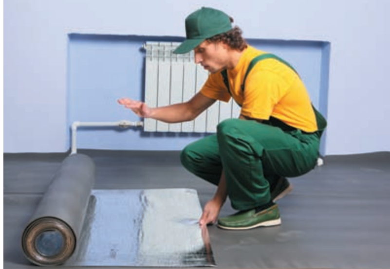
Рис. 3. Укладка теплоотражающего материала
