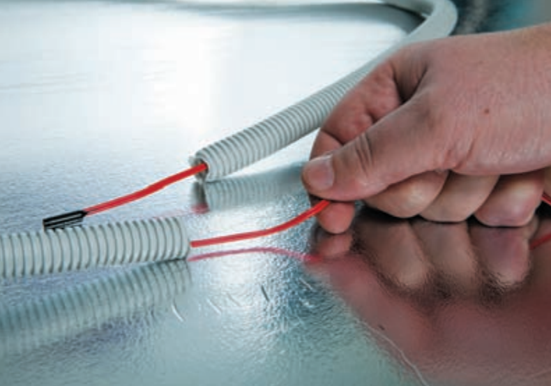
Рис. 18. Установка датчика температуры пола SF 4x15 в гофрированную трубку (конец).
