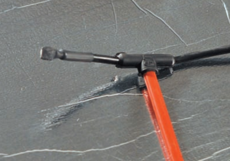
Рис. 5. Изоляция начала полосы UNIMAT
