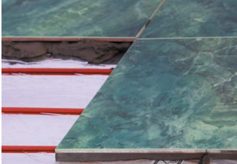
Рис. 26. Монтаж керамической плитки поверх карбонового мата UNIMAT RAIL/ UNIMAT BOOST
