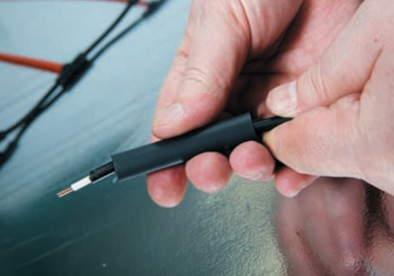
Рис. 11. Процесс надевания термоусаживаемой трубки на соединительный провод ВВГнг
