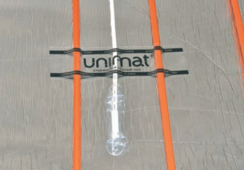
Рис. 16. Установка датчика температуры пола SU 8x25 между стержнями UNIMAT.
