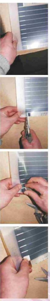
При использовании нагревательной пленки учтите, что предельная температура нагрева ламинированного паркета составляет 27 °С. Пол ковриками или мебелью температура покрытия может превысить предел, ограниченный установками терморегулятора. Для более подробной консультации обратитесь к изготовителю покрытия.
