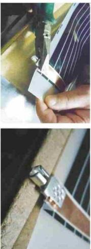
**3.2.7.** Полготовьте монтажные провода. Зажмите провод в цилиндрический разъем коннектора обжимными клемпами или плоскогубцами.
