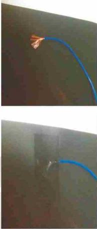
**3.3.4.** Провода укладывают по периметру комнаты в оставленный 50-миллиметровый промежуток или вырезанную в теплоизоляции штрабу, начиная с самой отдаленной от монтажной коробки полосы пленки. Закрепляют их скотчем. Примечание: Монтажные управляющие провода ни в коем случае не должны соприкасаться с нагревательным элементом.
