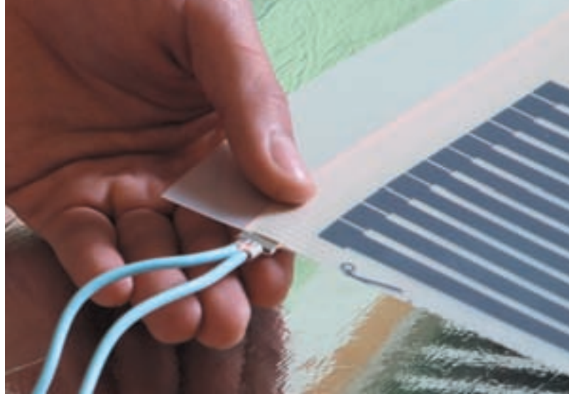
Рис. 15. Соединение монтажных проводов с контактным зажимом
