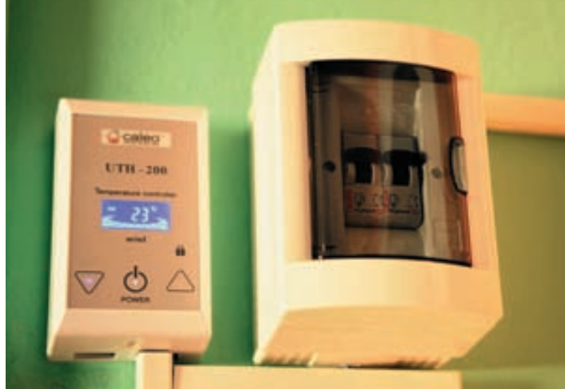
Рис. 27. Терморегулятор, подключенный к сети через отдельный автомат
