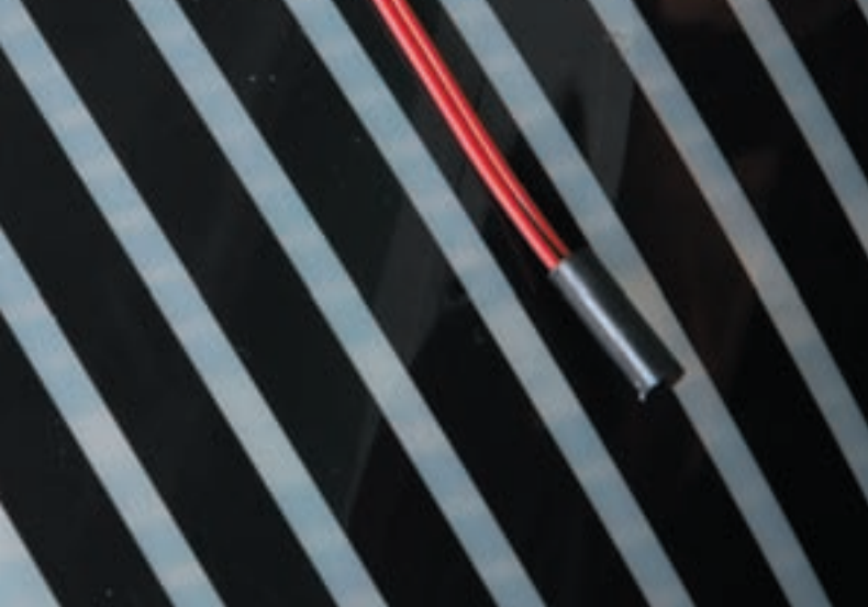
Рис. 22. Установка датчика температуры пола SF 4x15
