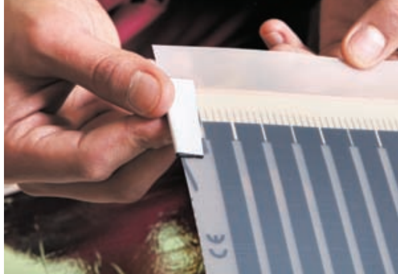
Рис. 14. Окончание процесса изолирования линии отреза медной шины
