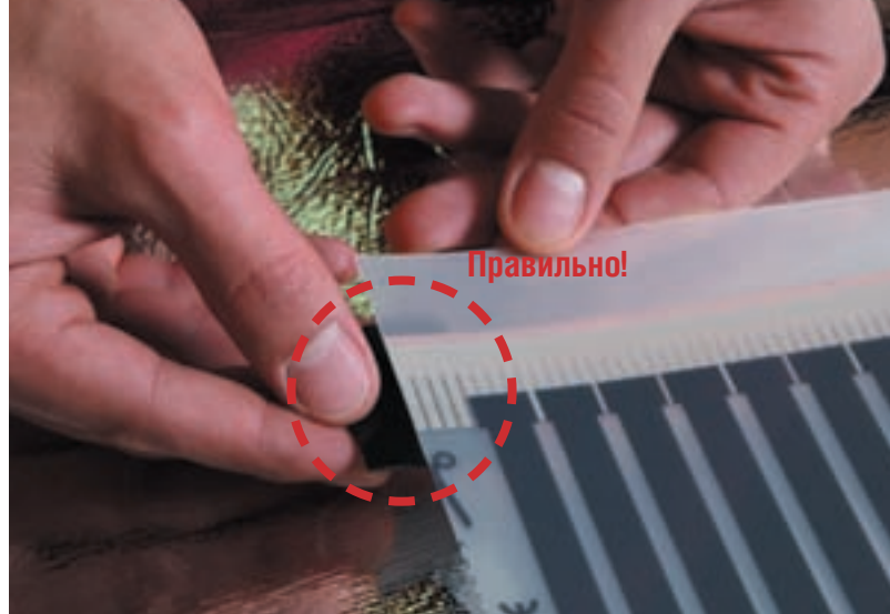
Рис. 12. Пример правильной установки изоляции линии отреза медной шины
