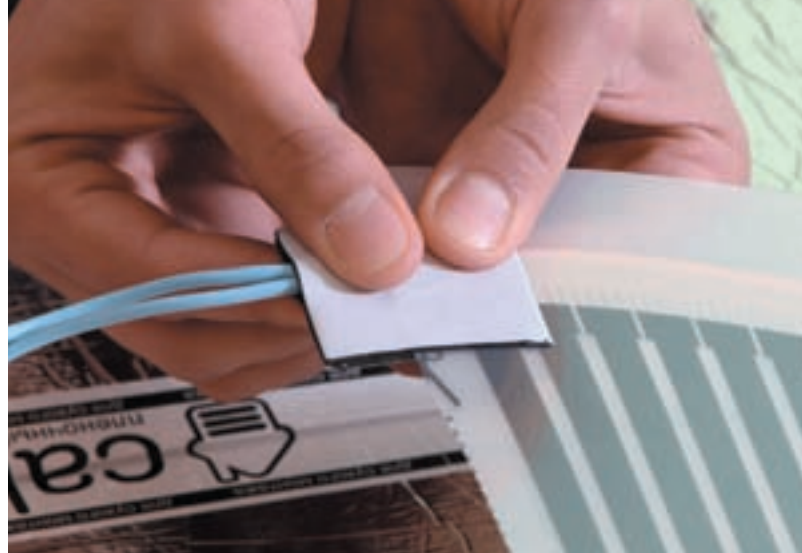
Рис. 19. Установка верхнего листа изоляции
