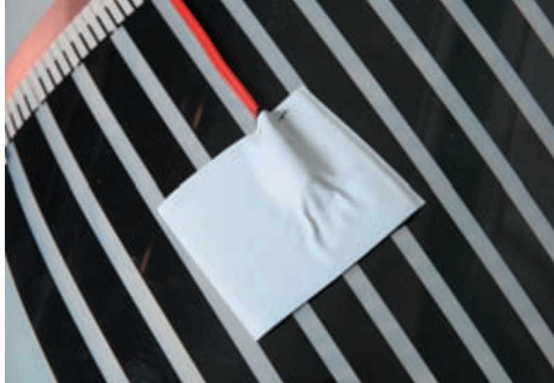
Рис. 25. Установленный и приклеенный датчик температуры пола. Вид снизу термолентки
