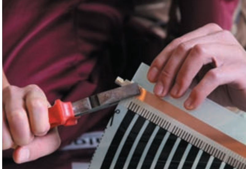
Рис. 10. Крепление контактного зажима к термопленке
