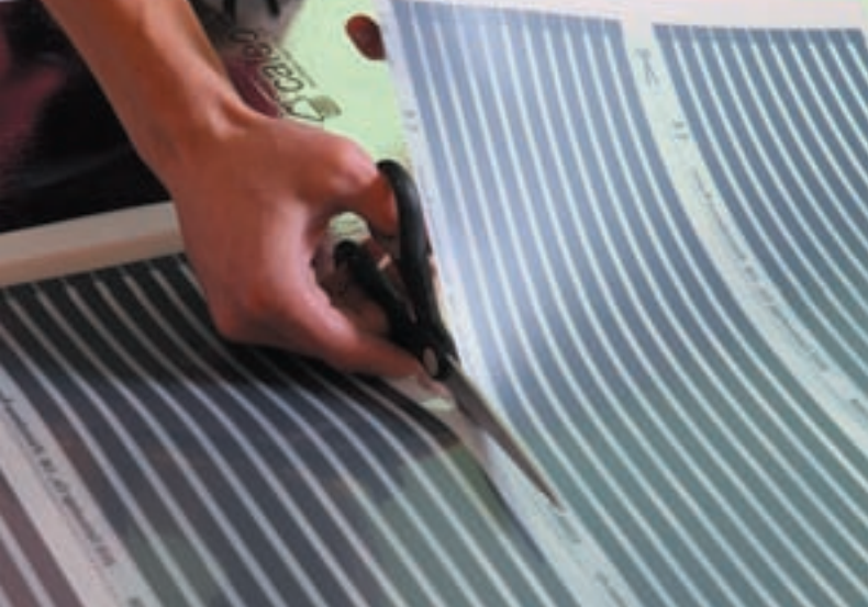
Рис. 7. Разрезание термопленки CALEO по линиям отреза
