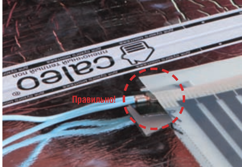
Рис. 17. Пример правильной установки нижнего листа изоляции контактных зажимов
