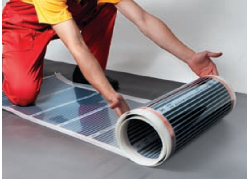
Рис. 5. Раскатывание рулона теплого пола на теплоотражающем материале
