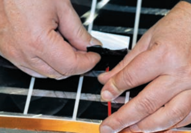
Рис. 24. Датчик прикрепляется к термопленке битумной изоляцией
