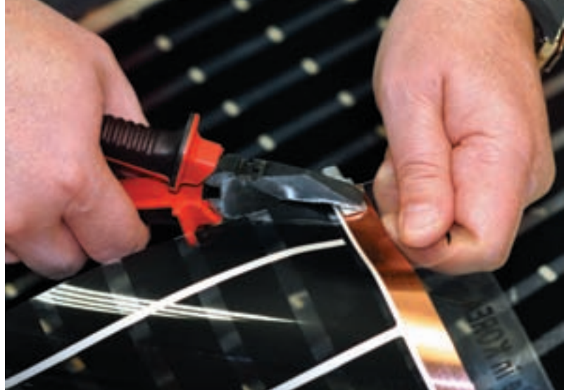
Рис. 10. Крепление контактного зажима к термопленке (обжатие плоскогубцами)
