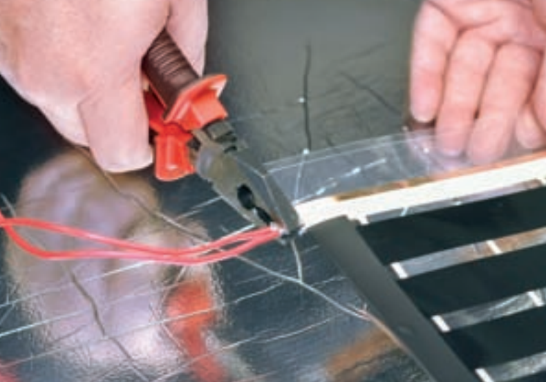
Рис. 16. Надежно зажмите провода в контактном зажиме
