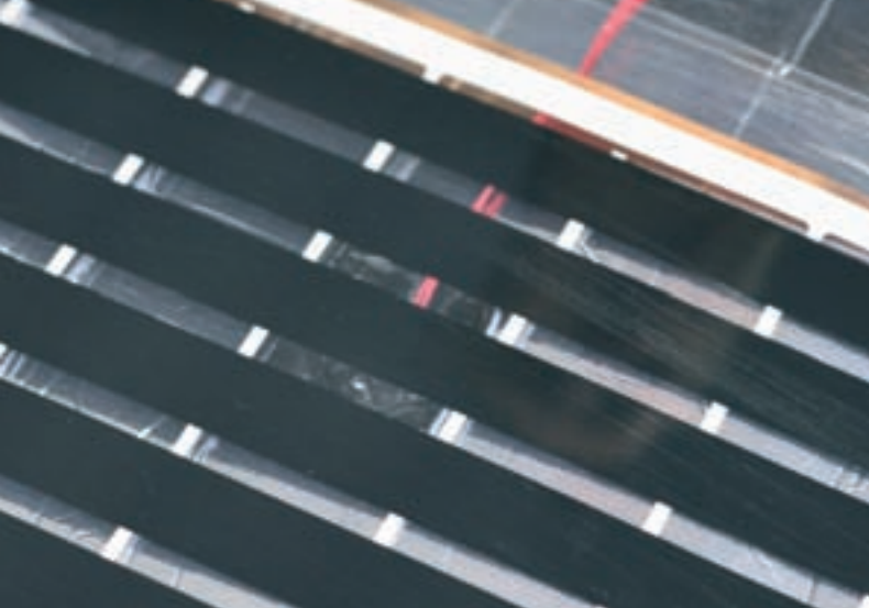
Рис. 26. Установленный и приклеенный датчик температуры пола. Вид сверху термопленки
