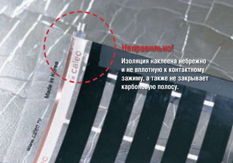
Рис. 13. Пример неправильной установки ПВХ изоляции
