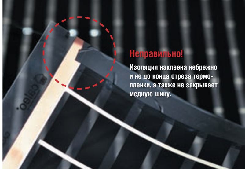
Рис. 14. Пример неправильной установки ПВХ изоляции
