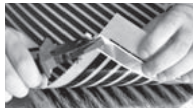
Рис. 6. Крепление контактного зажима к термопленке
