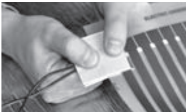
Рис. 14. Установка верхнего листа изоляции
