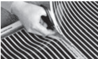
Рис. 4. Разрезание термопленки CALEO по линиям отреза
