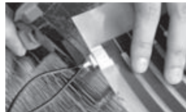
Рис. 12. Надежно зажмите провода в контактном зажиме
