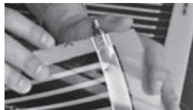
Рис. 5. Установленный на термопленку контактный зажим
