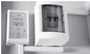
Рис. 20. Терморегулятор, подключенный к сети через отдельный автомат
